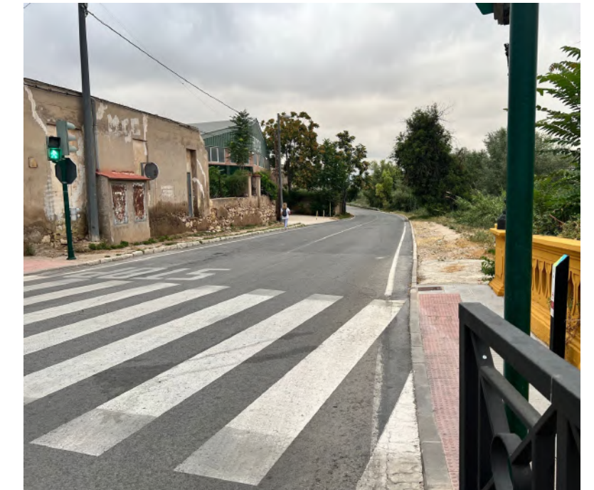
Ctra. Monforte: Recorrido hacia almacén de uva, en mal estado y sin zona peatonal.
