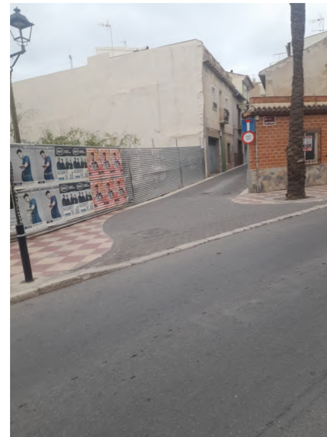
C/ San Pedro - C/ Águila: Cruce de calle sin continuidad, falta paso de peatones
