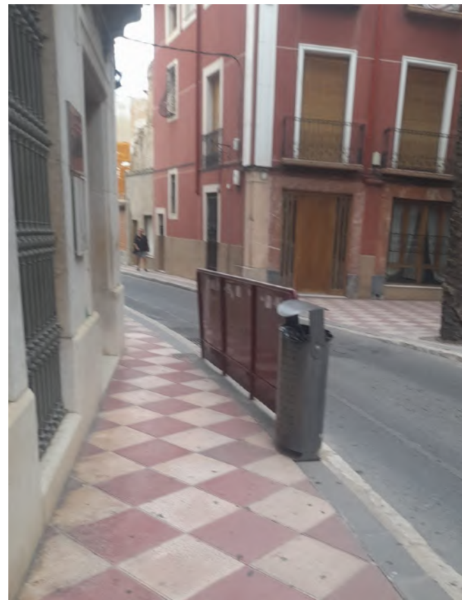
C/ San Pedro: Estrechamiento de acera impidiendo el paso con silla de ruedas o carrito de bebé
