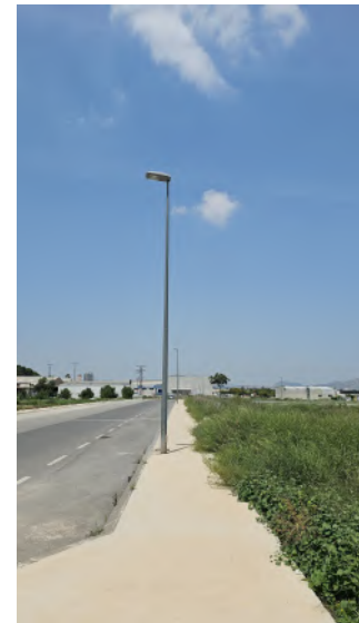
Camino Piedras. Farolas sólo a calzada.
