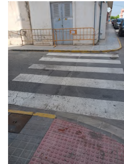
Calle Novelda. Paso de peatones sin vado, inseguro.
