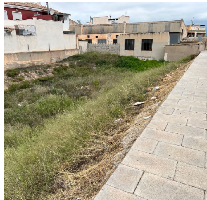
Av. del Castillo: Descampados con mucho desnivel no vallados, con posibilidad de caídas peligrosas
