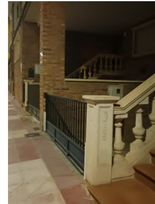
C/ Alcalde C. Carbonell: Entrada a viviendas con escaleras sin verja, creando recoveco
