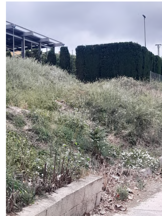
Av. Tres de Agosto: Desprendimientos de tierras sobre acera
